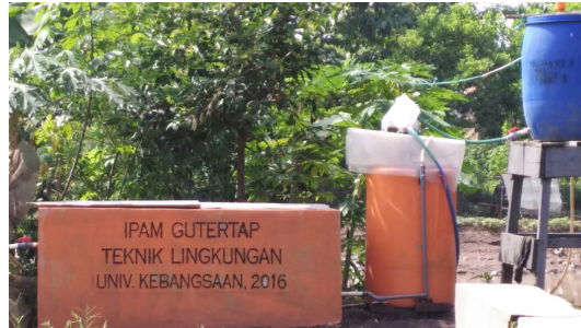
Gambar A3b. Instalasi Gutertap pengolahan air Citarum menjadi air minum. Sumber: Rosalina, 2016
