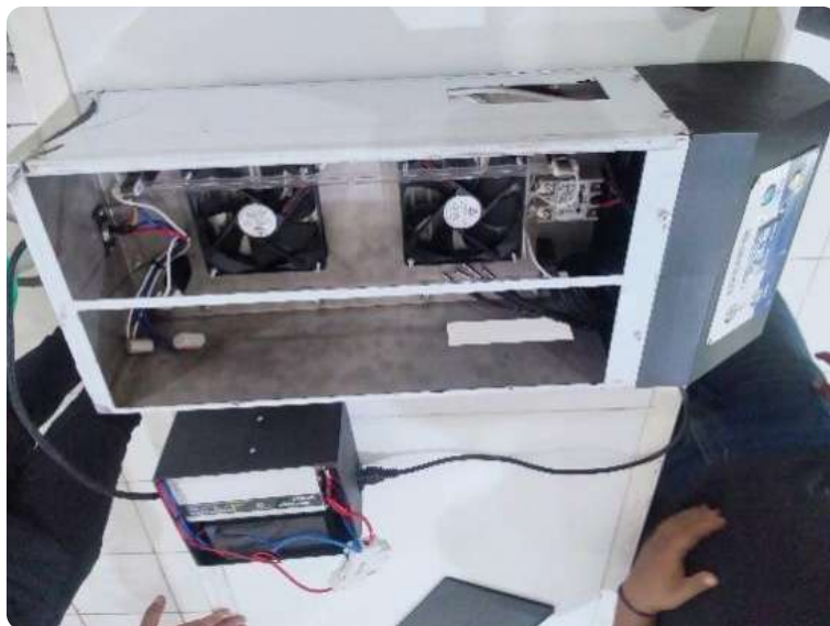
Gambar 4: Pemasangan kipas dan lampu heater
